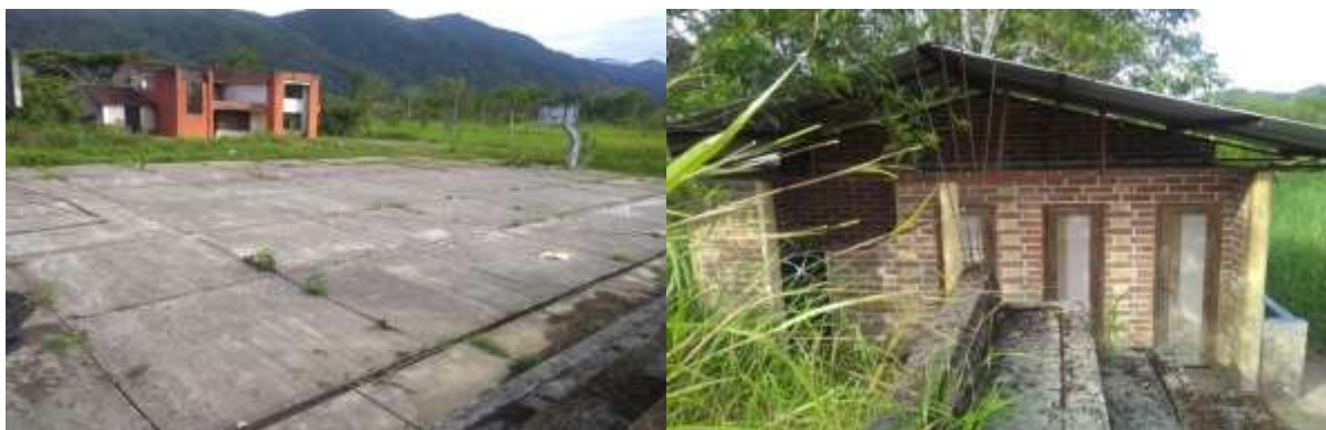
Ilustración 32. Cancha de uso múltiple y baterías sanitarias del barrio
