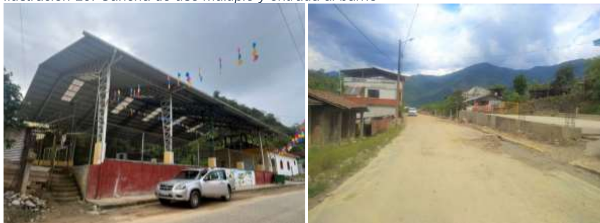
Ilustración 29. Cancha de uso múltiple y entrada al barrio
