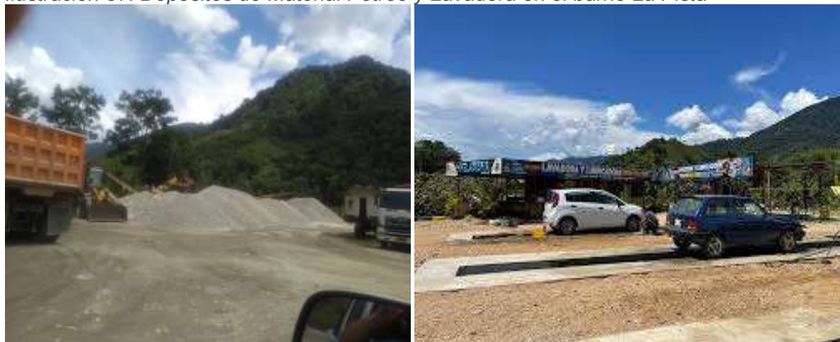
Ilustración 37. Depósitos de Material Pétreo y Lavadora en el barrio La Pista
