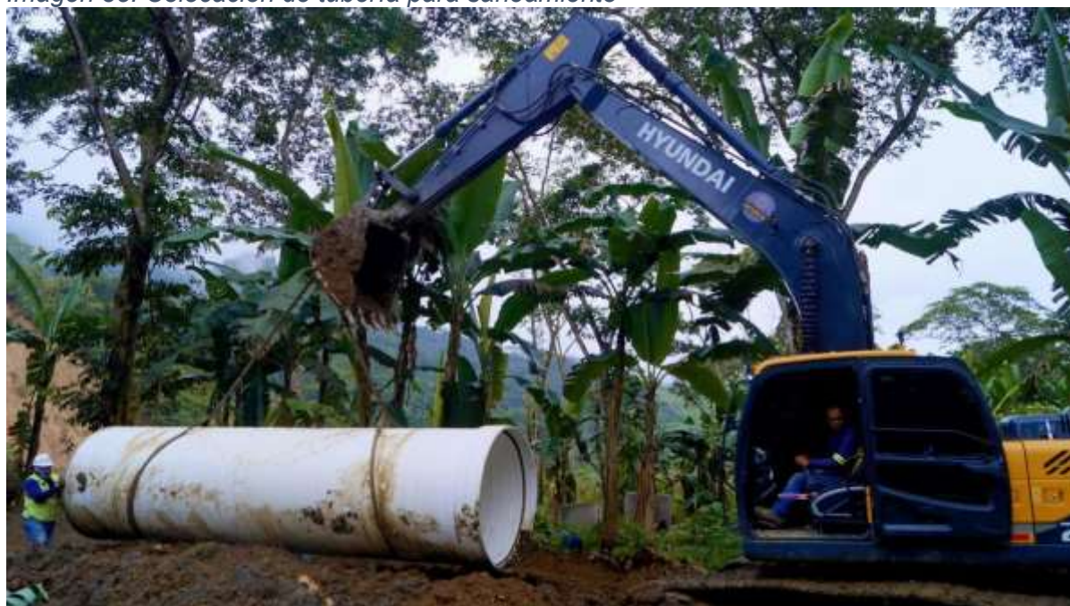
Imagen 35. Colocación de tubería para saneamiento
