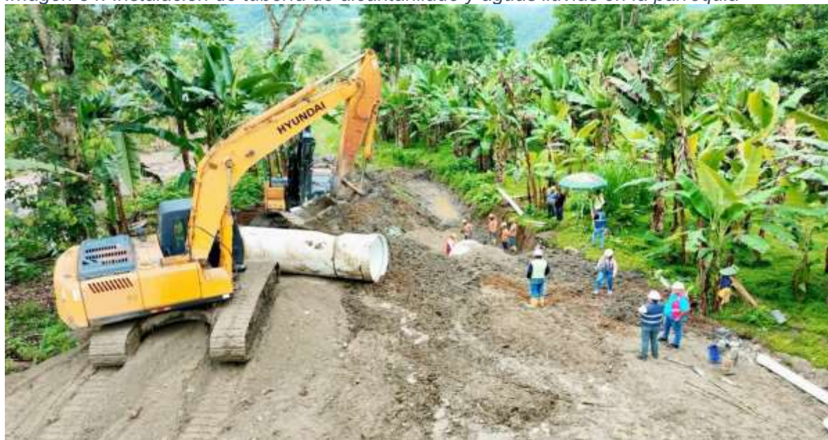
Imagen 34. Instalación de tubería de alcantarillado y aguas lluvias en la parroquia
